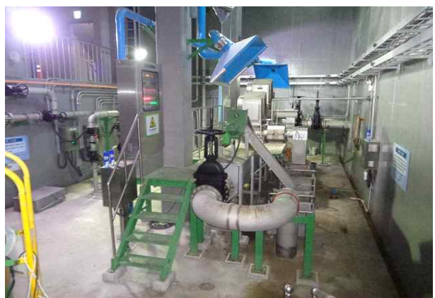
내부 지하2층 유량조정조 전경
