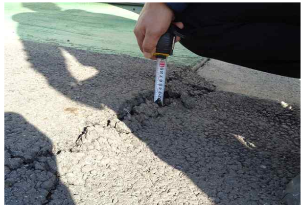
외부, 주변지반 침하 ( L=10.0\text{m} , t=30\text{mm} )
