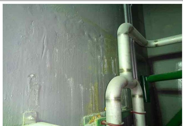
내부 지하2층 벽체 오염 ( A=1.0\text{m}\times 1.0\text{m} )
