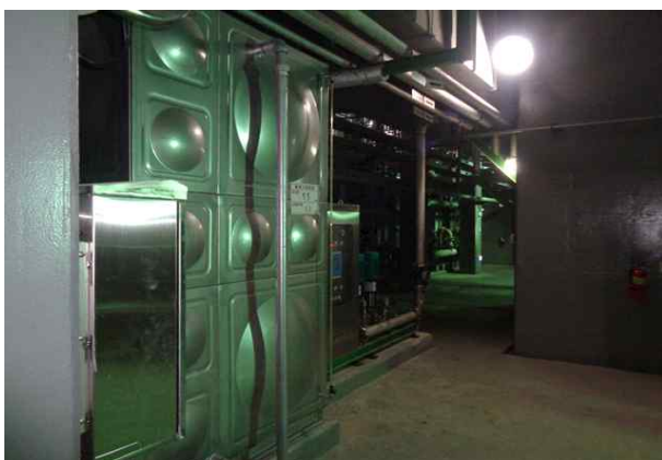
내부 지하2층 전경
