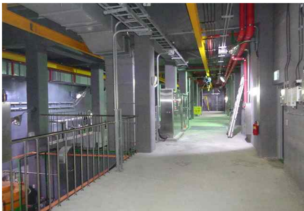
내부 지하1층 전경
