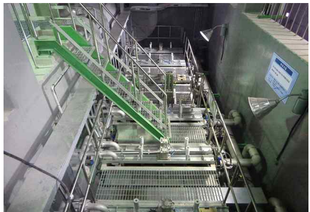
내부 지하1층 여과시설 전경
