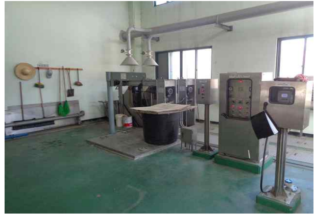
내부 1층 전처리실 전경
